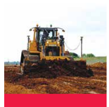
27 Satelliten helfen bei Erdarbeiten
