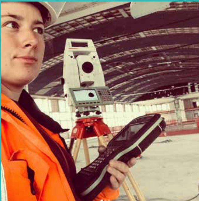
Gebäudesanierung in Den Haag, Niederlande, mit einer Leica TS16-Totalstation durch Marijke De Cleer.
